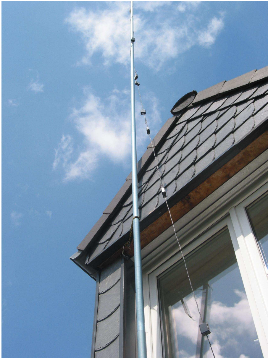
Bild 6: Blick auf die Antenne
